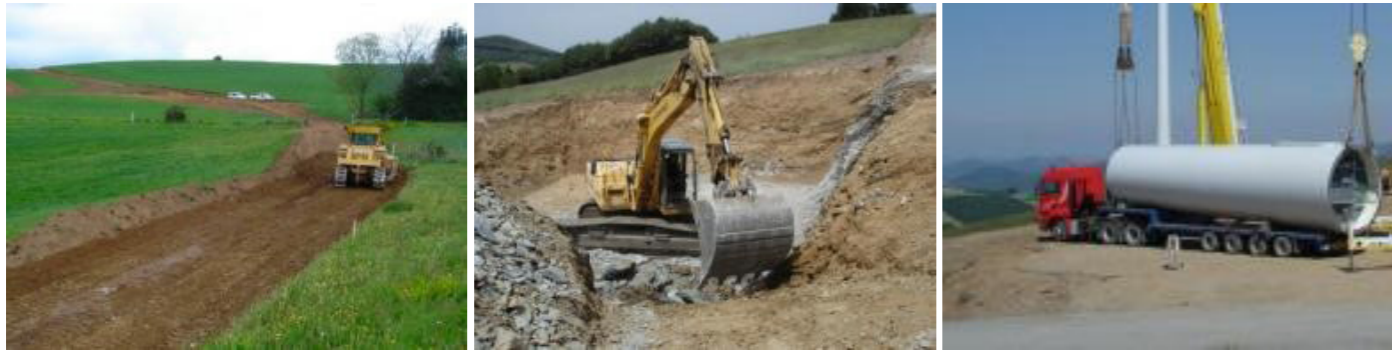
Photographie 115 : Illustration d'un chantier éolien
